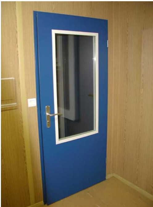
Beispiel: Türe 875x2000 mm mit Fixverglasung 550x1108 mm
