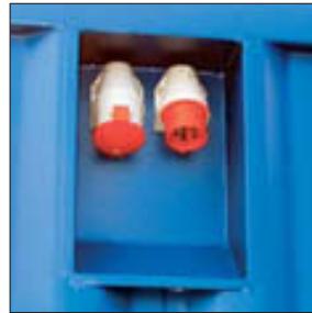
Versenkte CEE Anschlüsse an der Container-Rückseite
